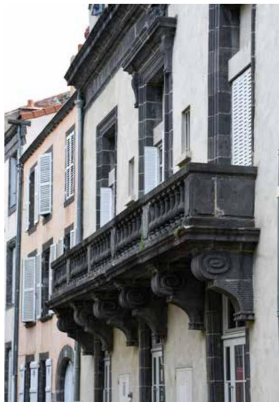
Lorsque le crépi est dégradé, il doit être complètement repris. Lors de son piquage\*, des éléments intéressants peuvent être mis à jour et laissés apparents dans la mesure où ils ne nuisent pas à la cohérence architecturale de l'ensemble. En revanche, les pierres isolées sur la façade présentant un caractère anecdotique seront enduites.
