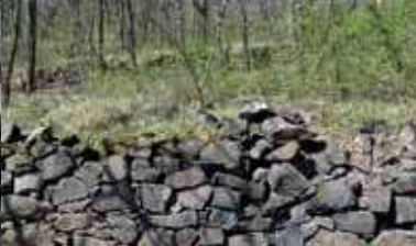
zone de terrasses à Riom
