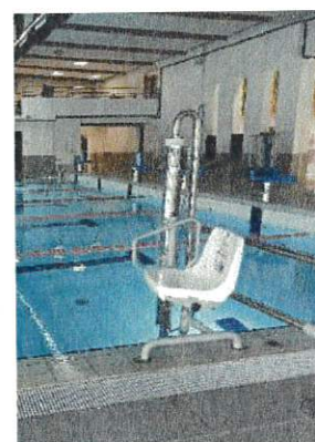
Potence de mise à l'eau sur les bassins de nages
