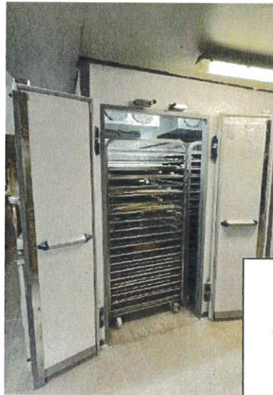
Boulangerie Garcia à Lussat, remplacement de la chambre de fermentation
