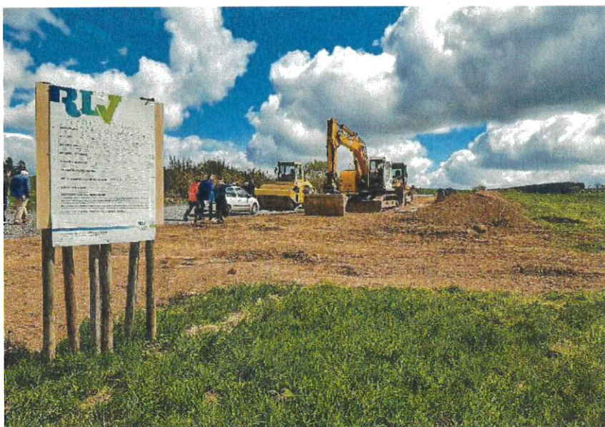
ZA de Pulvrières, phase chantier.
