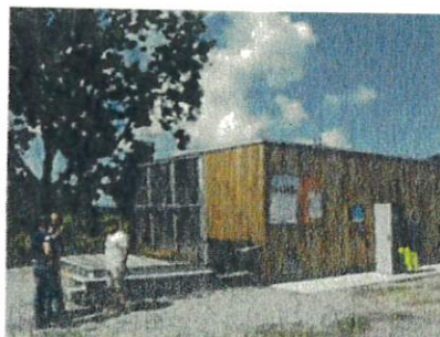
Visite de la chaufferie bois de Messelx
