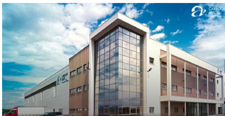
Usine pharmaceutique CARBOGEN AMCIS à Saint-Beauzire
