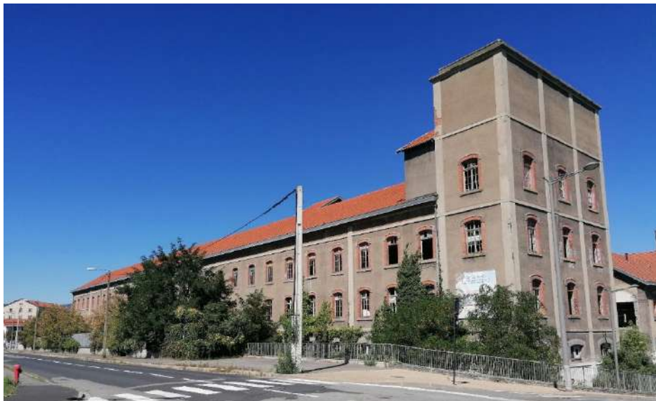
Bâtiment X de la manufacture des tabacs de Riom en friche depuis 1975
