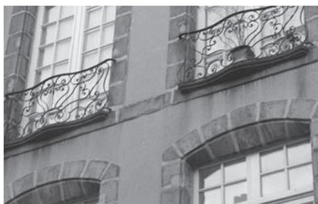
Photo e : balcons et bandeaux saillants en façade : couloires de salissures sur l'enduit plus importantes sous les balcons.
