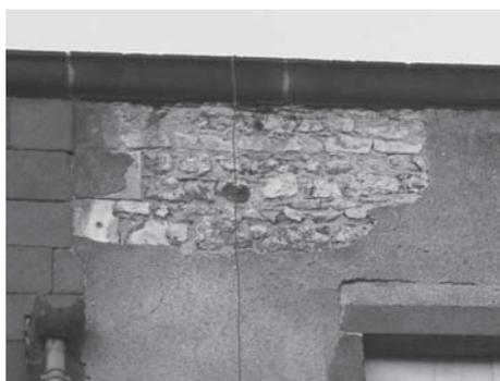
Photo c : défaut d'étanchéité sur corniche
