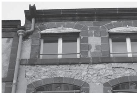
Photo d : bandeau saillant en façade : décollement de l'enduit
