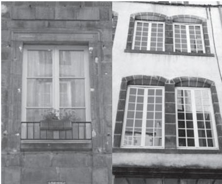
Restitution des **fenêtres** composées selon leur époque soit de vantaux à petits bois multiples (12, 18 carreaux ou plus par vantail), soit de vantaux plus simples à 3 ou 4 carreaux.
