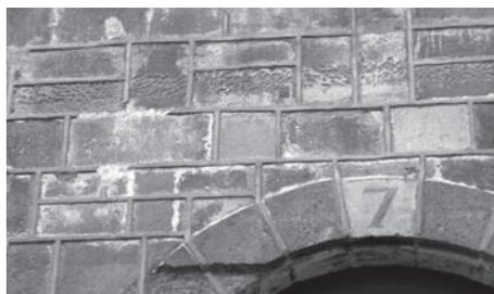
Les joints en ruban sont à proscrire. En surépaisseur ces joints en ciment empêchent les joints de mortier de chaux et la pierre de respirer. De plus lors de leur piquage, la dégradation de la pierre sera importante. Les joints situés entre les appareils en pierre de taille se font oublier (photo f). Pour ce faire, ils doivent être exécutés dans le même matériau que le crêpi et être coupés à la truelle, non lissés ni creusés.
