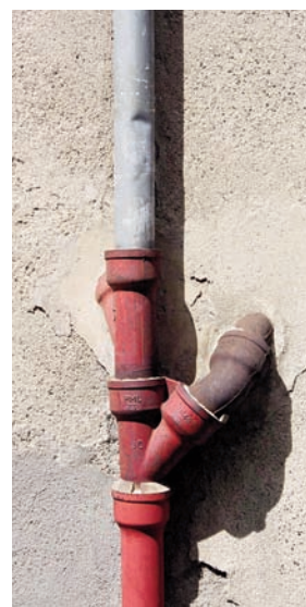
raccordement non conforme
